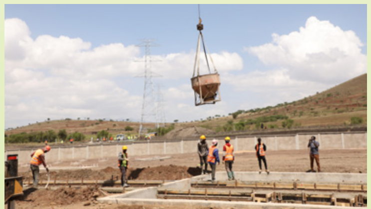
Mafundi wakiendelea na shughuli mbalimbali za ujenzi wa miuondombinu ya mradi wa kusafirisha umeme wa Singida hadi Namanga mkoani Arusha, Desemba 15, 2020.
